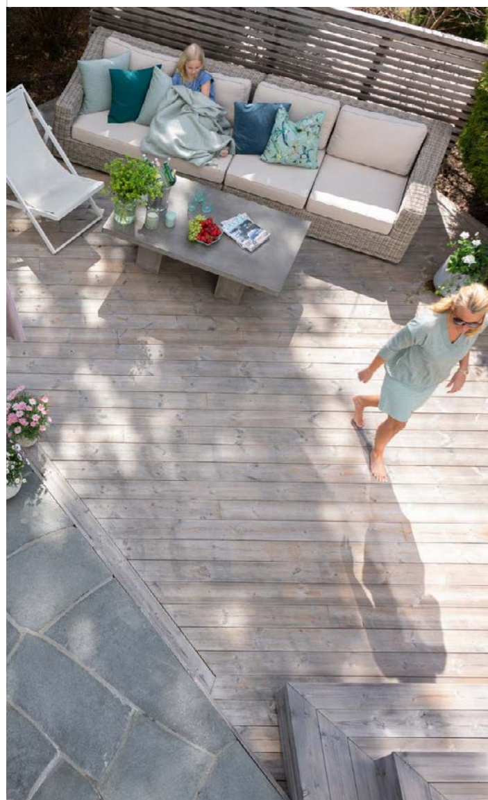
Õlitamata Thermory Benchmark termomännist terrass ca 1 aasta möödudes. Foto ja distributsioon: Moelven Norway
