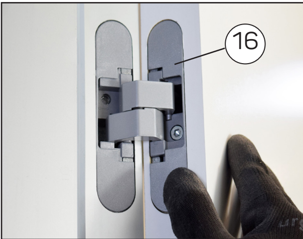
2G. Hinged [16] reguleerime vastavalt lisatud juhised, kasutades kuuskantvõtit [20], seadistades need nii, et ukse ja lengi vahele jääksid võrdsed vahed ning et uksepind oleks profiili esipinnaga samal tasapinnal. Seejärel pange hingedele korgid [16]
