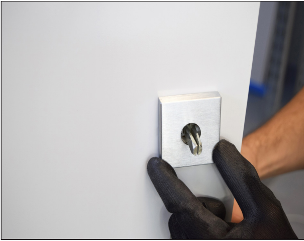
2E. Paigaldage rosett ja uksekäepideme tihvt
